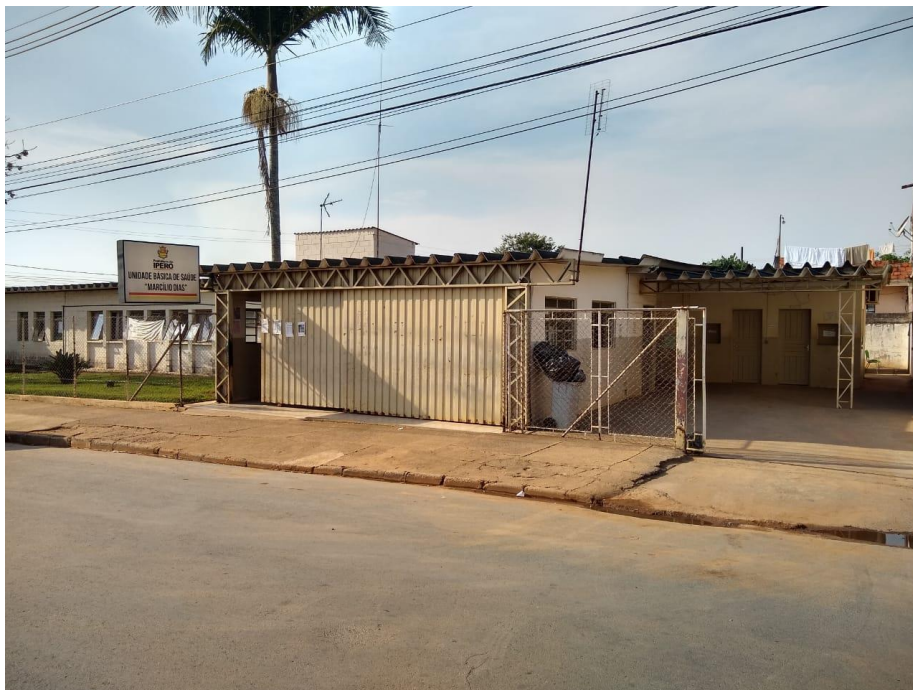
Figura 1 - Fachada da UBS
